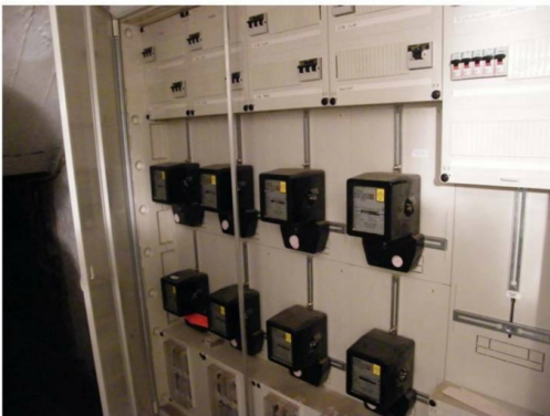
Neue Elektrikinstallation in beiden Häusern
